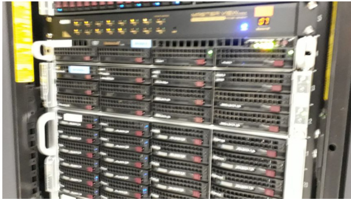
Dans la salle données informatiques de l'entreprise Réseau Concept à Dijon © Radio France - Stéphanie Perenon
